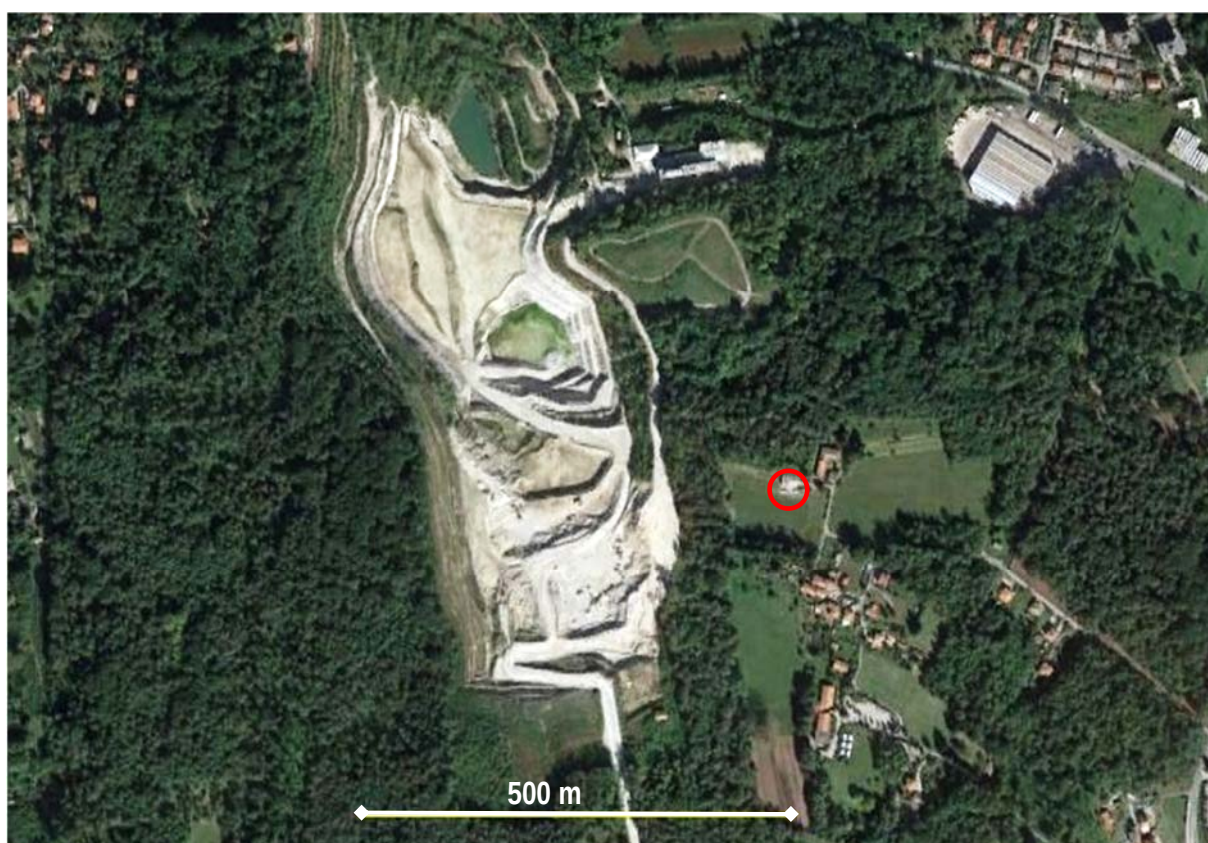
Fig. 2 Punto di posizionamento della centralina di monitoraggio PM 10
