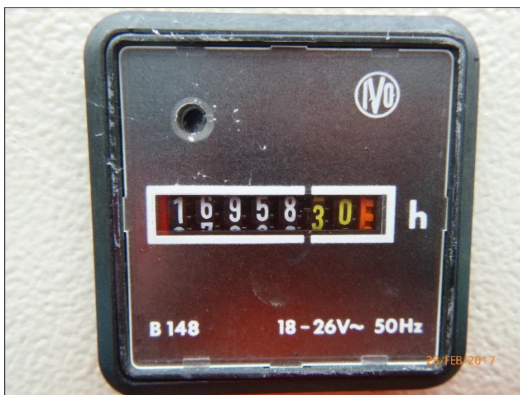
Foto 1: ore di lavoro rilevate in data 28 febbraio 2017
